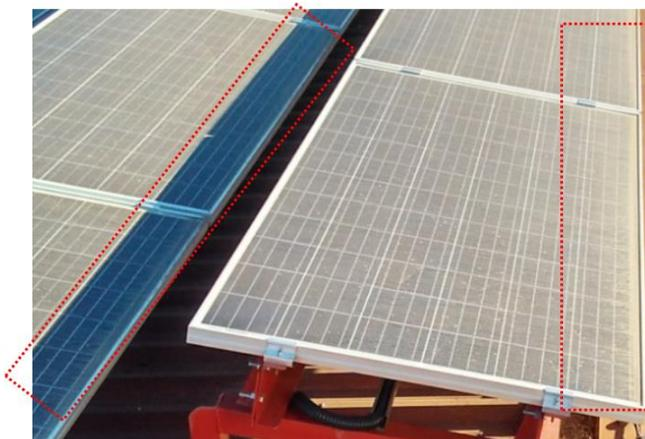
Figura 8: Regiões do módulo mais afetadas por sujeira e sombreamento nos módulos em orientação paisagem.
