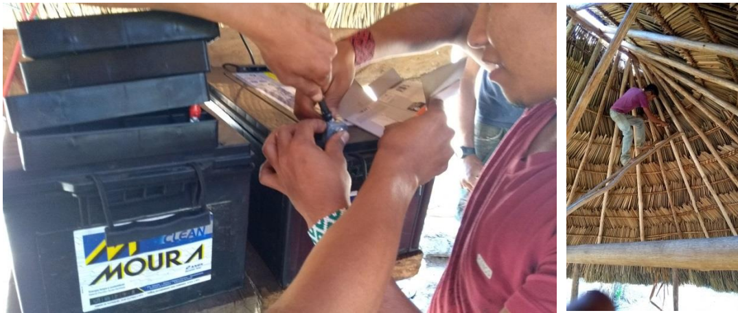
Figura 6 - Processo de instalação dos sistemas fotovoltaicos.
