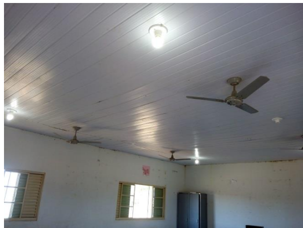
Figura 11 - Forro de PVC comumente utilizado em prédios de alvenaria no TIX.
