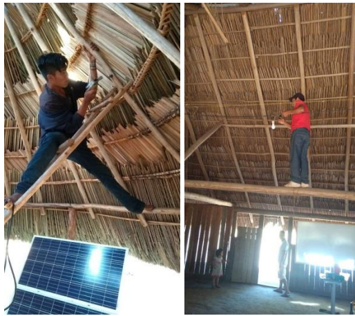
Figura 10 - Instalações elétricas e trabalhos em altura.
