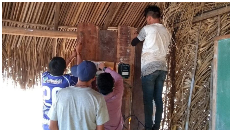
Figura 9 - Construção de estrutura para fixação do quadro de condicionamento de potência.
