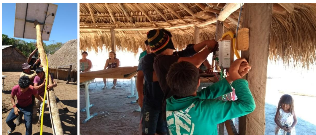
Figura 5 - Processo de instalação dos sistemas fotovoltaicos.
