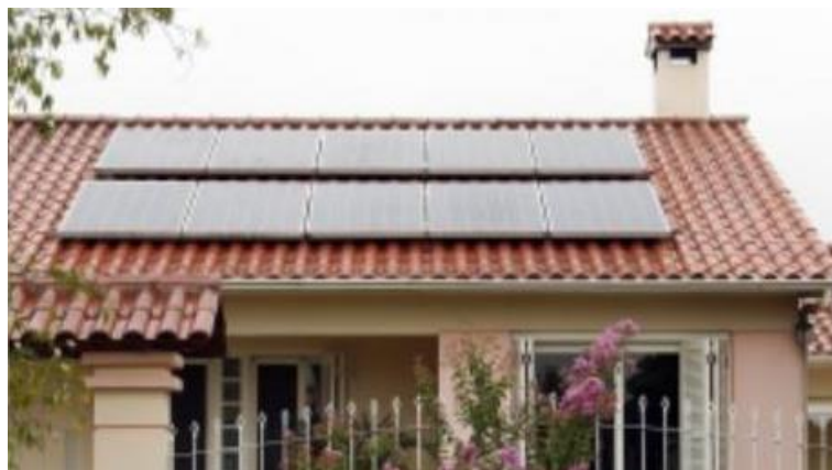
Figura 6 - Sistema PV de Silício Policristalino da Residência Bellinaso. Fonte: Lucas Bellinaso.
