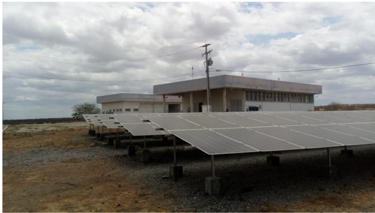
Figura 1 – Microusina solar de 62,7 kWp da UFERSA, Campus Angicos.
