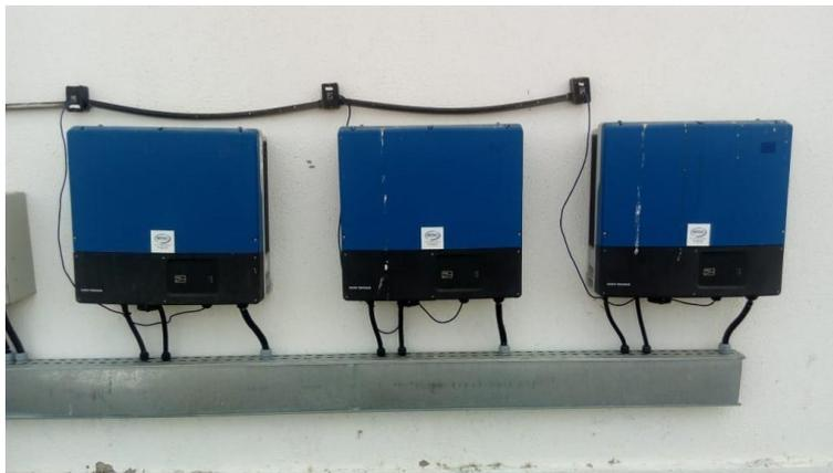
Figura 2 – Disposição dos inversores.
