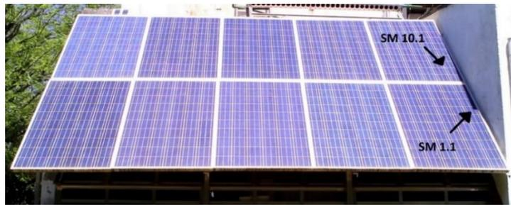
Figura 11 – Foto do sistema FV com os submódulos sombreados indicados por volta das 12h e 30 min.
