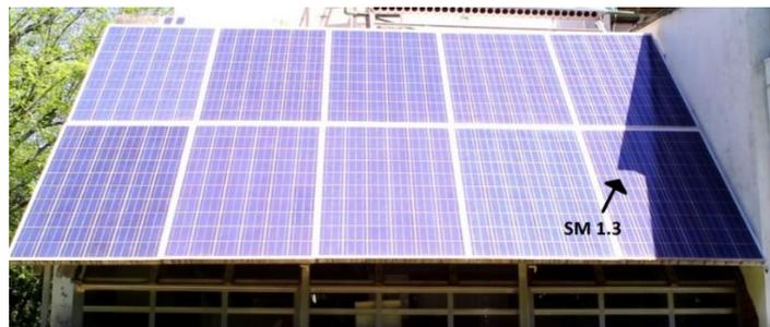
Figura 14 – Foto do sistema FV com o submódulo sombreado indicado por volta das 14h.
