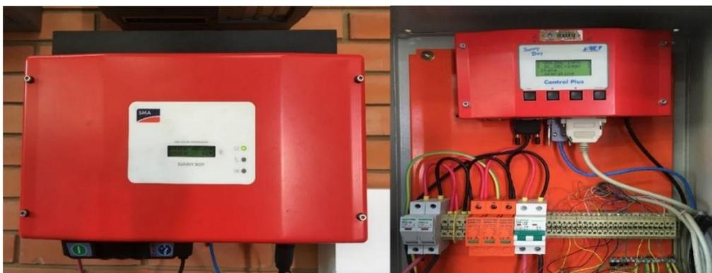
Figura 6 – Inversor e equipamento de aquisição de dados.
