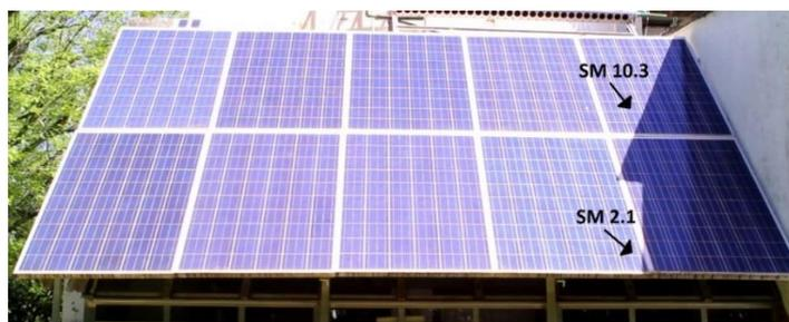
Figura 15 – Foto do sistema FV com os submódulos sombreados indicados por volta das 14h e 30 min.
