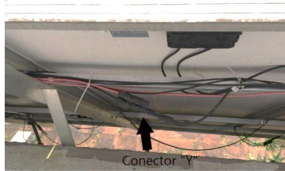
Figura 7 – Conector "Y" utilizado para medição de tensão individual dos módulos FV.
