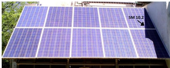
Figura 13 – Foto do sistema FV com o submódulo sombreado indicado por volta das 13h e 30 min.
