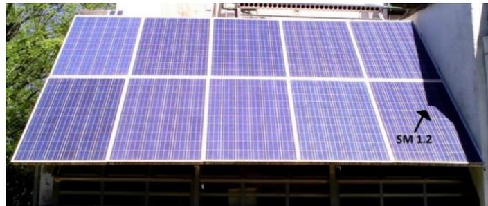
Figura 12 – Foto do sistema FV com o submódulo sombreado indicado por volta das 13h.
