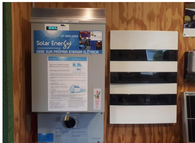
Figura 2 - Inversor instalado no Escritório Verde.
