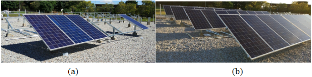
Figura 5 – Instalação da estrutura metálica Fonte: Souza, Mariano e Urbanetz (2020)
