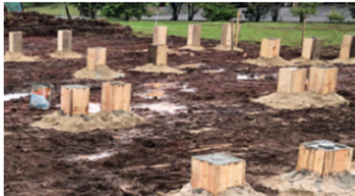
Figura 4 – Preparação das sapatas Fonte: Souza, Mariano e Urbanetz (2020)
