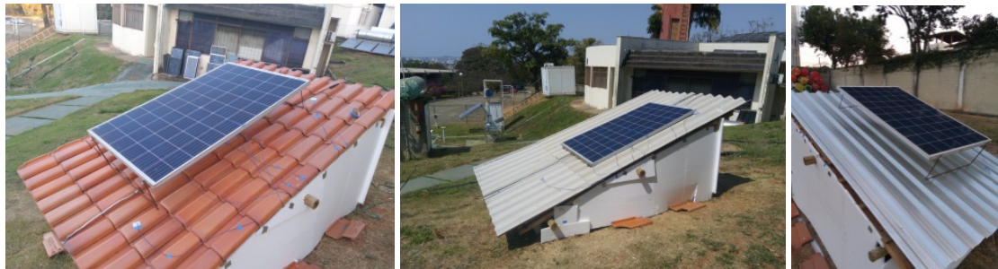
Figura 6 - Bancada usada na coleta dos dados de campo para a validação do modelo matemático (da esquerda para a direita: telhado de cerâmica vermelha, telhado de fibrocimento, telhado de aço galvanizado).
