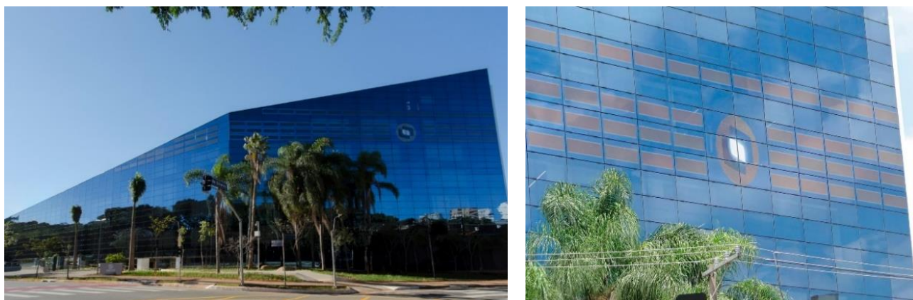
Figura 11 - Instalação de OPV em fachada vertical realizada pela empresa Sunew. (a) Vista do prédio (b) detalhes da fachada. Fonte: Sunew
