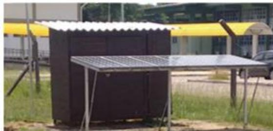
Figura 1 - Configuração do sistema SIGFI 45, gerador com seis módulos de 85 Wp.
