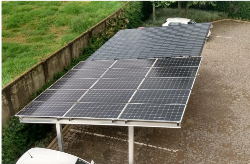
Figura 2 – Instalação do Carport
