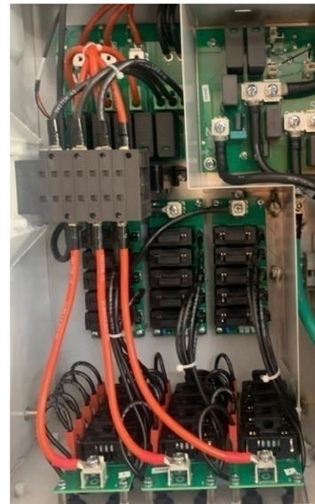
Figuras 4 e 5 – Indicação das conexões das *strings* na parte externa do inversor e verificação da parte interna do inversor (lado CC), destacando-se os 3 circuitos para os MPPTs.
