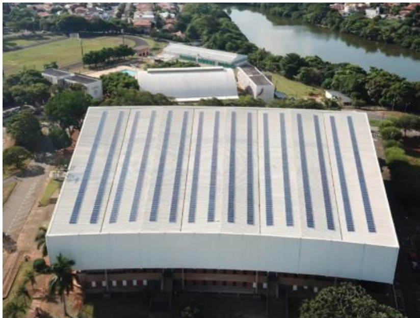
Figura 1 - Visão superior do telhado do GMU com o sistema FV instalado.
