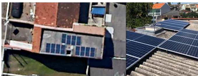
Figura 5. Módulos instalados na Residência Boqueirão (DO AUTOR)
