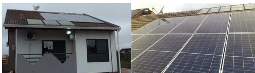
Figura 10. Módulos instalados na Residência Bom Retiro (DO AUTOR)
