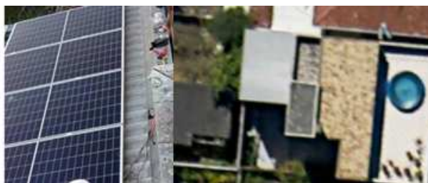
Figura 8. Módulos instalados na Residência Cristo Rei (DO AUTOR)
