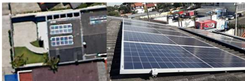
Figura 4. Módulos instalados na Residência Tingui (DO AUTOR)
