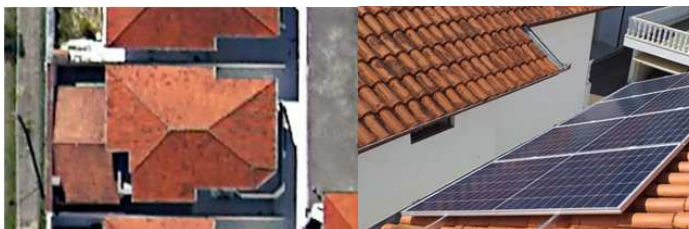
Figura 9. Módulos instalados na Residência Ahu (DO AUTOR)
