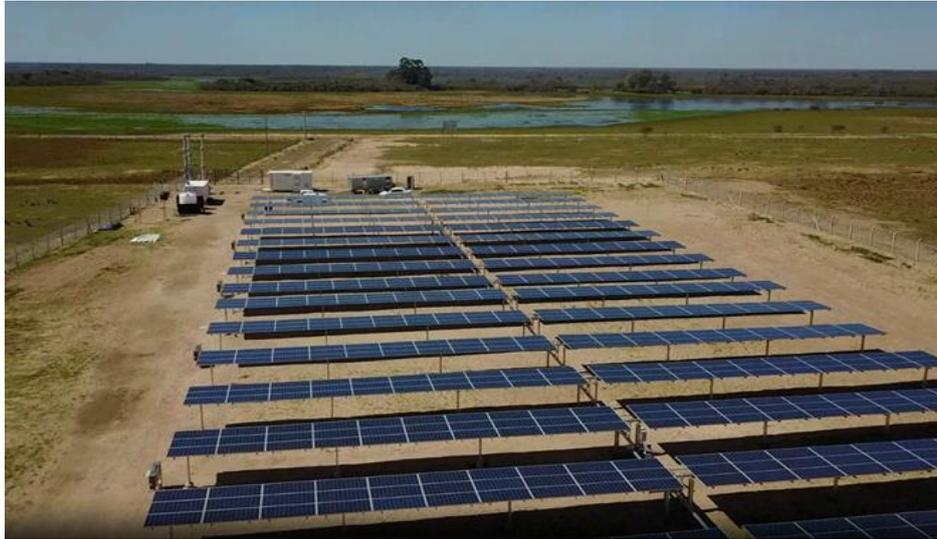
Figura 3- Vista general, tomada a través de un dron, de la microrred hibrida solar/Diesel/batería localizada en Paraje Malvinas Corrientes.
