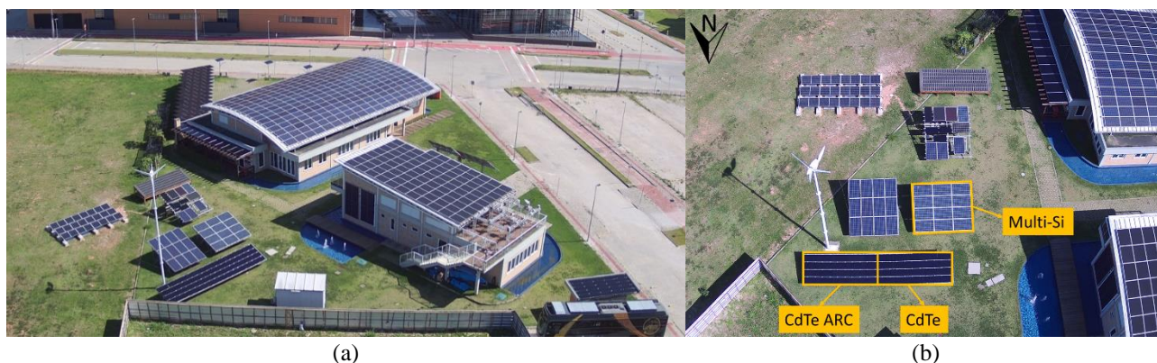
Figura 1 - Imagem aérea do laboratório Fotovoltaica-UFSC em Florianópolis-SC (27,4°S; 48,4°O) (a), e vista dos sistemas em solo do laboratório, destacando os três sistemas analisados neste estudo (b).
