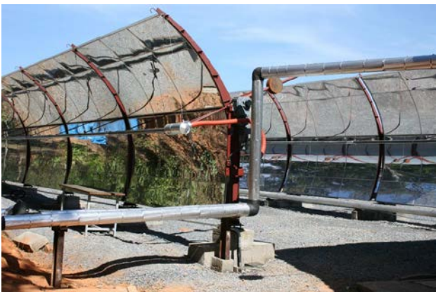
Figura 4 (a) - Instalação do CEFET-MG / CEMIG.
