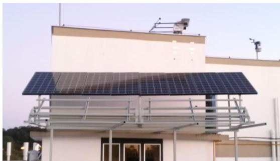
Figura 2 - Estrutura formando o painel FV composto por oito módulos policristalinos modelo KD135SX-UPU da Kyocera (2013).
