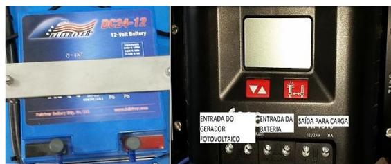
Figura 5- Acumulador eletroquímico e controlador de carga.
