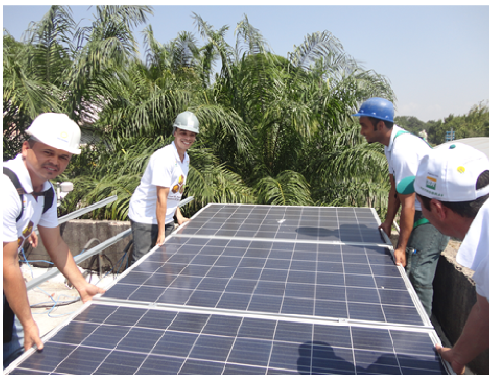
Figura 3- Aula prática sobre instalações fotovoltaicas conectadas à rede.
