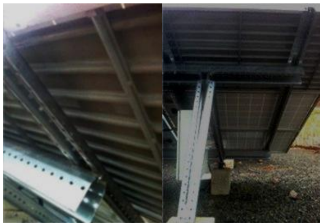
Figura 8 - Sistema arrefecedor/módulo PV instalado na UFV.
