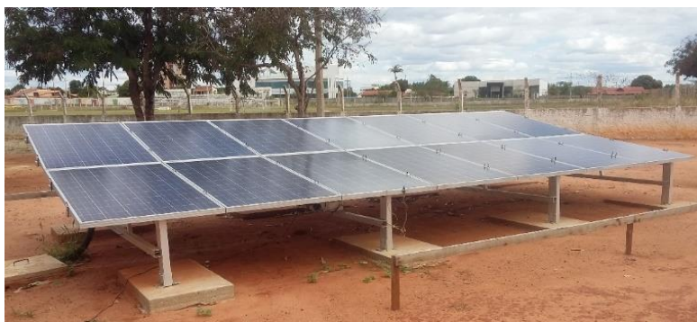
Figura 2 – Módulos fotovoltaicos YL245P - 29b, Yingli Solar.
