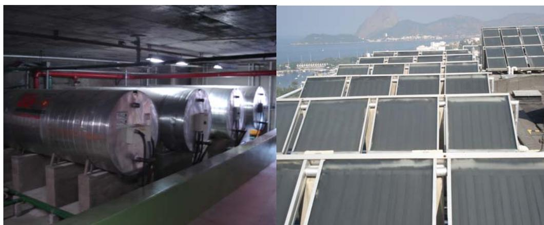
Figuras 12 e 13: Coletores e reservatório instalados no EDISE. (Fonte: Petrobras)
