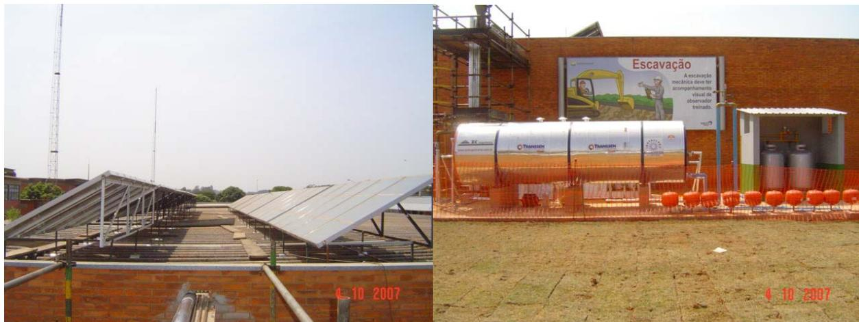
Figuras 8 e 9: Coletores e reservatório instalados na REPLAN. (Fonte: Petrobras)
