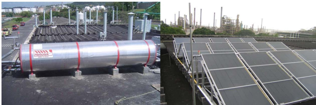
Figuras 6 e 7: Reservatório e coletores instalados na RLAM. (Fonte: Petrobras)
