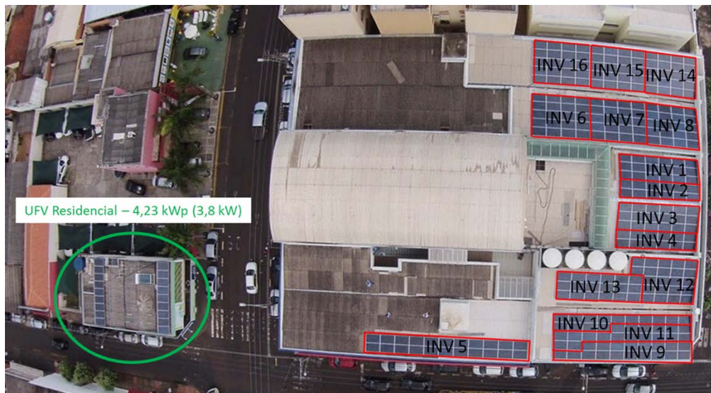
Figura 9 – Vista aérea, com identificação dos inversores (Id.), da UFV Miramontes (68,62 kWp, à direita) e UFV Residencial (4,23 kWp, à esquerda).
