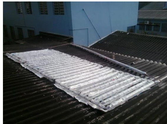
Figura 6 – Coletor solar térmico artesanal para aquecimento de água instalado no telhado da Escola.
