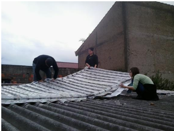
Figura 6 – Coletor solar térmico artesanal para aquecimento de água instalado no telhado da Escola.
