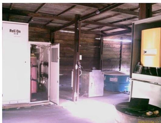
Figura 6- a) Arranjo fotovoltaico e abrigo do SHGD; b) CaC, eletrolisador, reservatório e inversores instalado no CPC.
