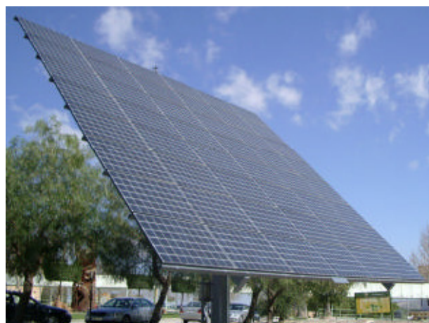
Figura 11 – Protótipo de seguidor com dois eixos e painéis planos localizada na Universidade de Jaén, Espanha.
