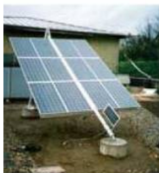
Figura 6 – Seguidor solar do tipo polar com painel auxiliar. (Oliveira, 2008)
