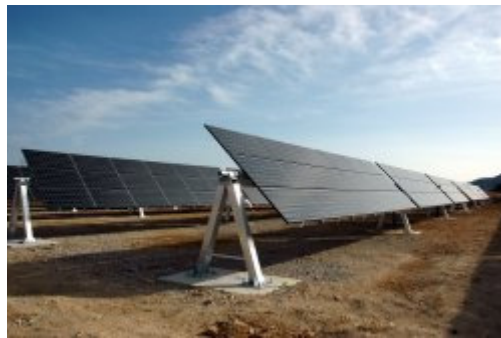
Figura 8 – Seguidor solar do tipo horizontal (Wattsun HZ-Series). Fonte: http://www.wattsun.com/commercial_gallery.html
