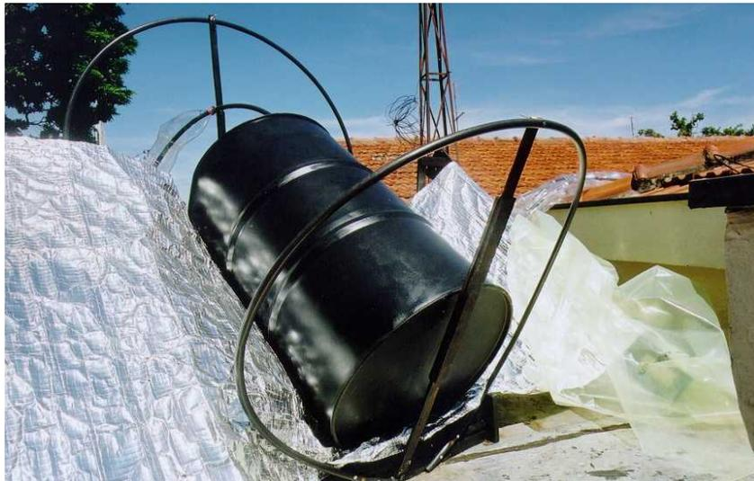
Figura 1: Aquecedor solar de baixo custo sendo instalado na laje da residência. São visíveis o tambor, a malha de alumínio e o plástico de estufa que cobrirá o aquecedor
