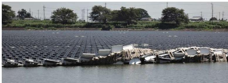
Figura 1- Acidente com usina fotovoltaica flutuante. Local: Kawajima-machi – Japão.
