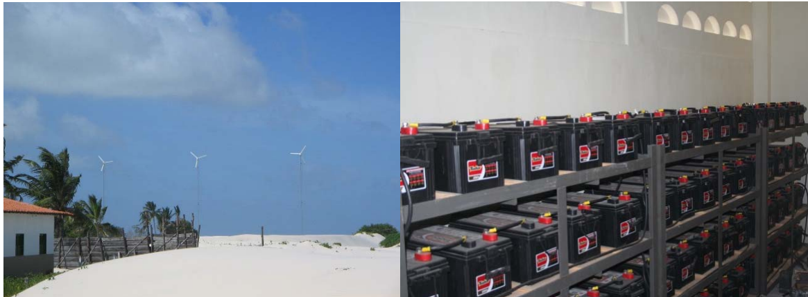
Figura 3 – Turbinas de 7.5 kW e baterias de 150Ah.
