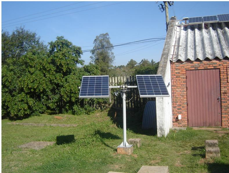
Figura 5 – Seguidor com módulos fotovoltaicos instalados
