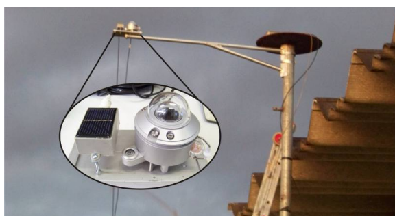
Figura 5- Sensores expostos à radiação solar.
