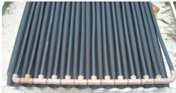
Figura 5. Detalhe das conexões na parte inferior do coletor.
