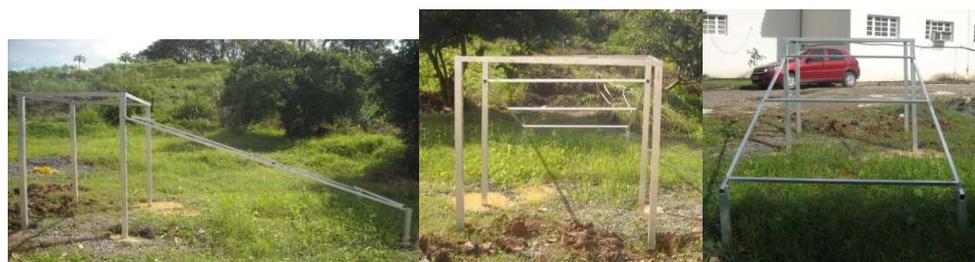
Figura 3. Detalhes da montagem do suporte em alumínio.
