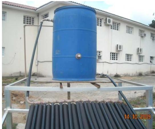
Figura 6. Detalhes das conexões na parte superior do coletor.
