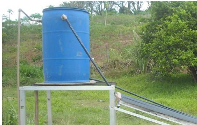
Figura 8. Tambor de PE para armazenamento de água quente.
