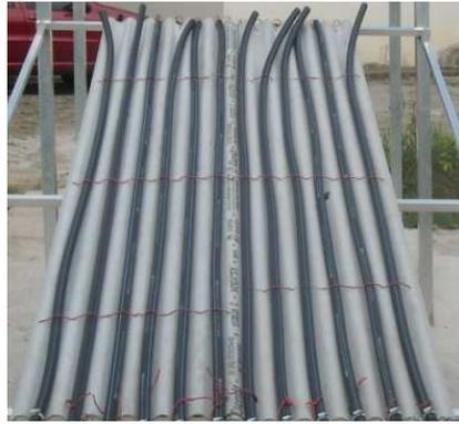
Figura 4. Detalhe dos 12 tubos de PEAD da grade absorvedora.
