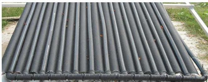
Figura 1. Detalhe das conexões dos tubos de PEAD com os T(tês) de PVC pintados de preto.
