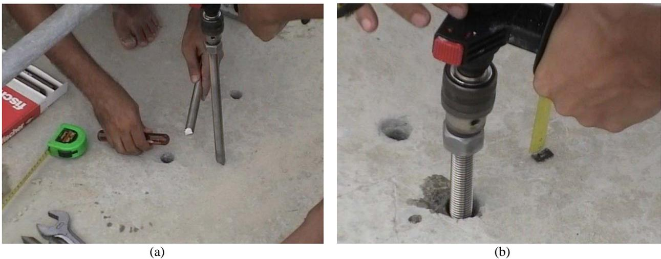
Figura 5 - (a) Aplicação do chumbador químico; (b) Peça adaptada fazendo a mistura com o parafuso.
