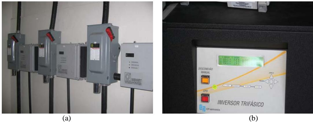
Figura 7- (a) Chaves dos aerogeradores; (b) Inversor
