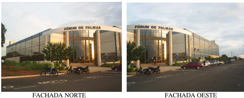
Figura 1 - Vista externa da edificação
