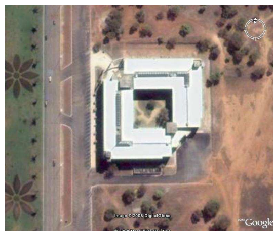
Figura 03 – Imagem aérea do edifício
