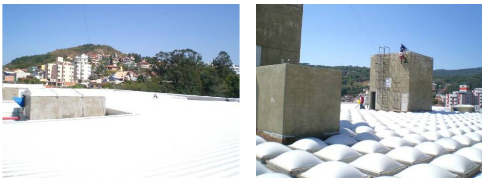
Figura 6 (a e b). Detalhes da cobertura: telhas metálicas e domus para iluminação zenital. (Arquivo pessoal)
