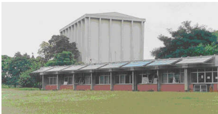
Figura 2 - Sistema de 12 kW p , integrado na fachada do prédio da administração do IEE-USP.
