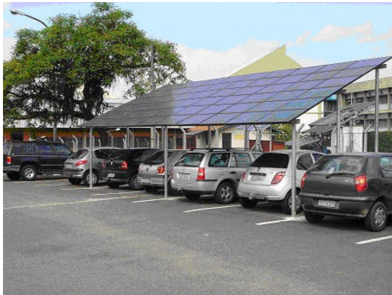
Figura 3 - Sistema fotovoltaico integrado a um estacionamento do IEE-USP. Produção de eletricidade ao mesmo tempo em que fornece sombra aos carros.
