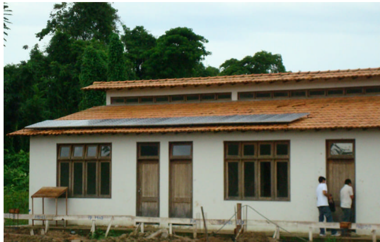
Figura 4 - Sistema fotovoltaico integrado ao telhado do laboratório do Grupo de Estudos e Desenvolvimento de Alternativas Energéticas (GEDAE).
