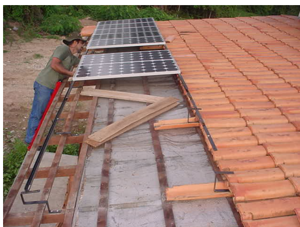
Figura 10 - Instalação do gerador fotovoltaico.
