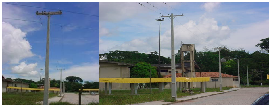
Figura 16 – Rede dedicada a ser utilizada para alimentação do prédio.
