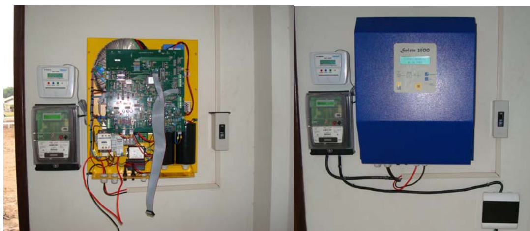
(a) Instalação do inversor
