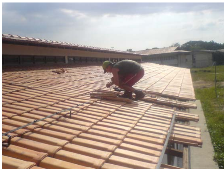
Figura 6 - Detalhe de fixação dos pés e da estrutura inferior.
