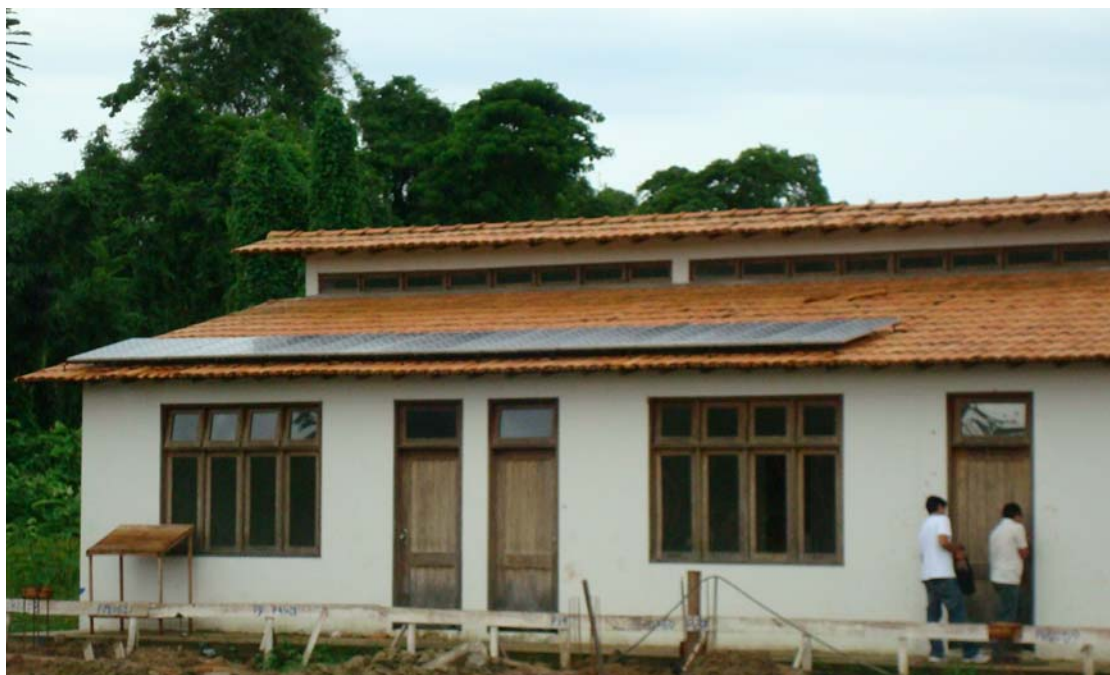
Figura 4 - Vista do 1º SFCR da região amazônica, integrado à edificação do GEDAE.
