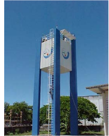
Fig. 5 – Torre para montagem da Estação Solarimétrica de Natal.
