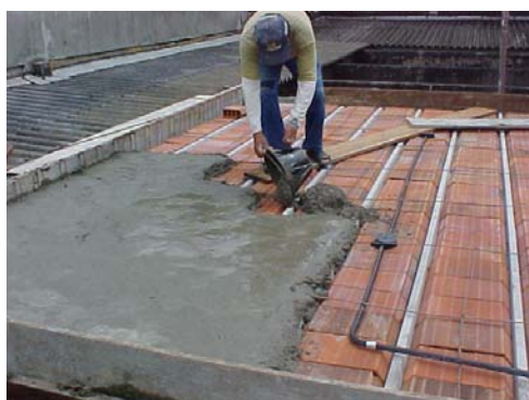
Fig. 1 – Concretagem da laje do Laboratório de Transferência de Calor – LTC, da UFRN.
