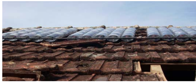
Figura 9 - Coletor solar com materiais recicláveis instalado em residência em Vila Dois Rios, Ilha Grande, RJ
