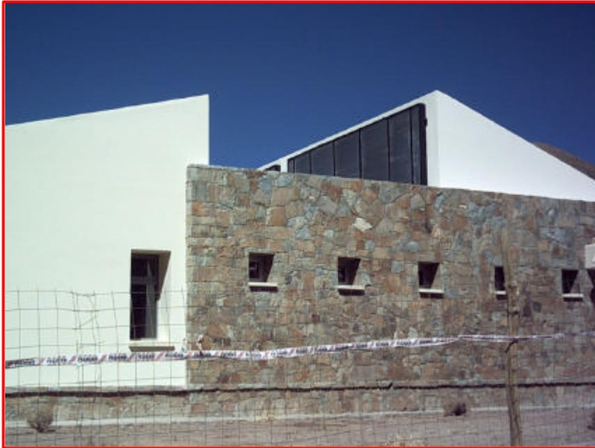
Figura 3 - Vista de la fachada Oeste donde se aprecia el doble muro de piedra y de bloque cerámico revocado (al exterior) y piedra cuarcita (al interior) en otro. En la azotea se observa una parte de los colectores calentadores de aire forzados.
