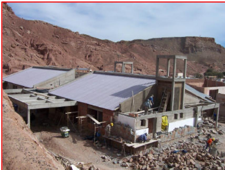
Figura 4 - Vista general del edificio con las fachadas Este y Sur en construcción donde se aprecia el doble muro con la aislación térmica en su interior.
