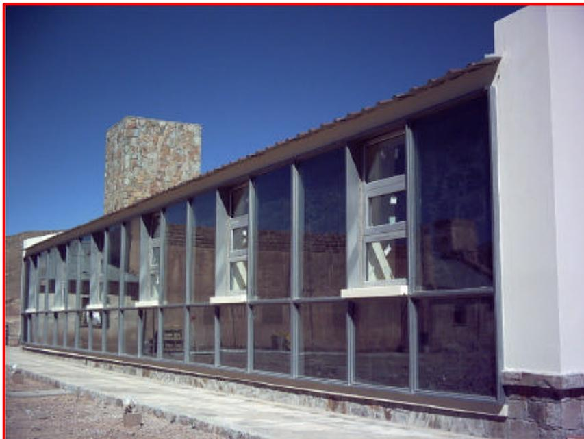
Figura 2 - Vista de la fachada Norte con el Trombe de cuarcita y las ventanas para ganancia directa.
