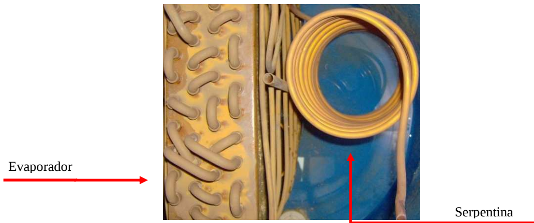
Figura 5 – Evaporador e serpentina de cobre no reservatório da URL
