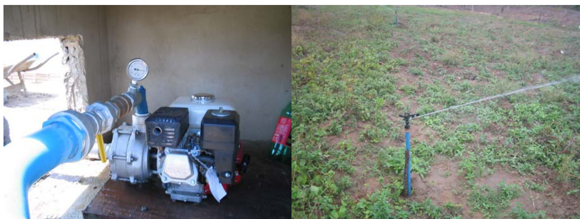
Figura 3: Conjunto motor-bomba e sistema de irrigação por aspersão
