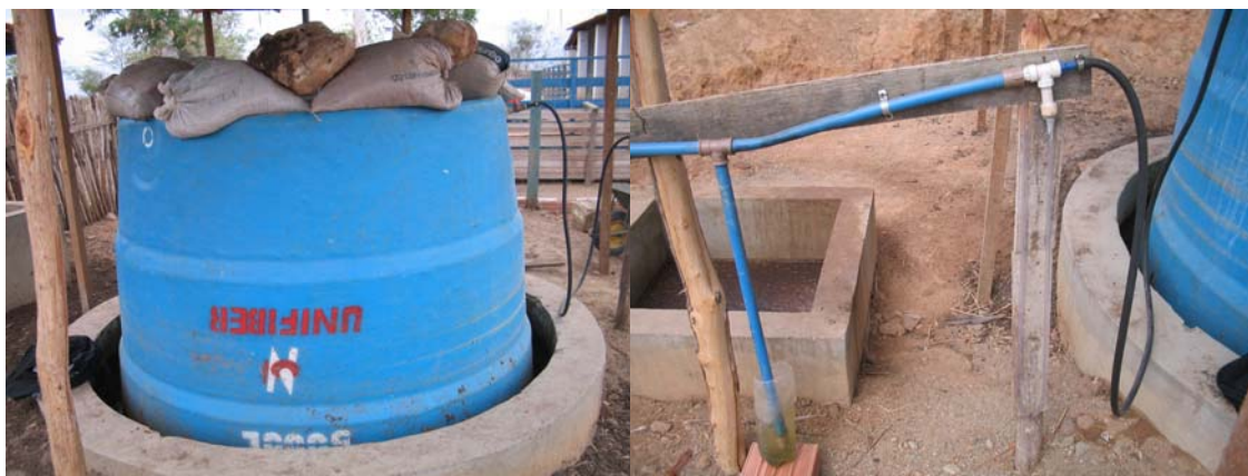
Figura 5: Gasômetro com pesos para o controle da pressão e tubulação com manômetro e ponto para coleta de água.
