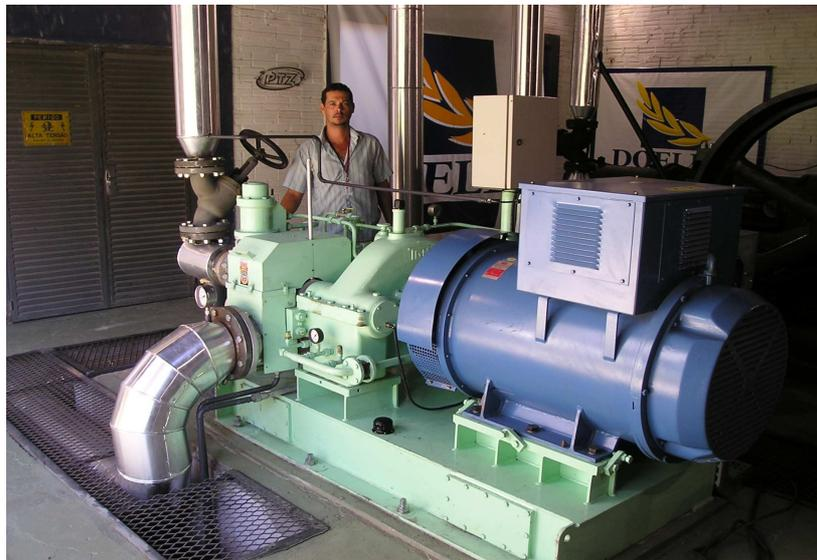
Figura 2 - Sistema modular do turbogerador com potência de 280kW.
