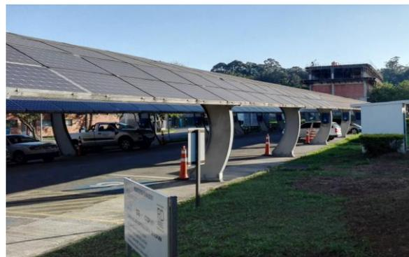
Figura 4 - Sistema fotovoltaico fixo instalado no estacionamento do IEE/USP.
