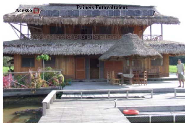
Figura 11 – Novo posicionamento dos módulos fotovoltaicos.
