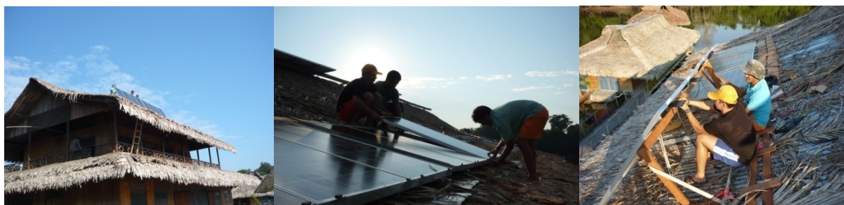
Figura 12 – Etapas da instalação dos módulos fotovoltaicos.
