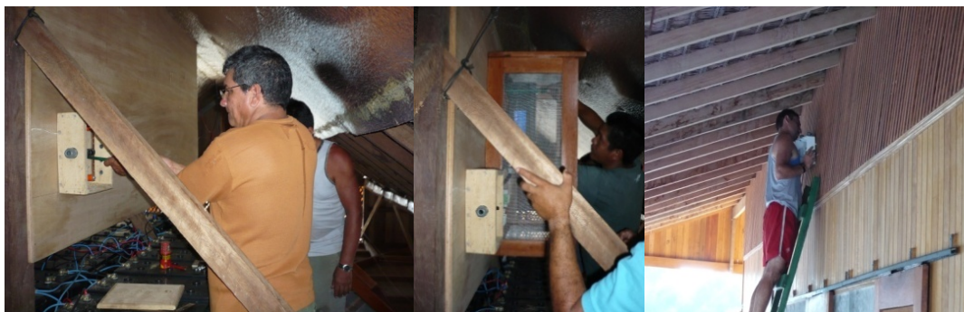
Figura 10 - Montagem das caixas trabalhadas na etapa anterior.
