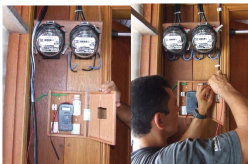
Figura 19 – Instalação dos medidores de energia e voltímetro digital.
