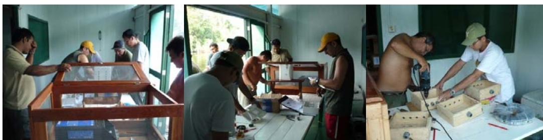
Figura 9 – Confecção dos barramentos e caixas auxiliares.
