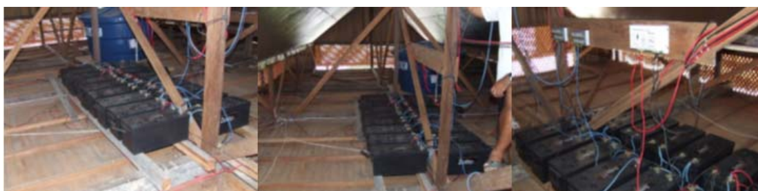
Figura 7 – Banco de baterias em 12 volts e detalhes das conexões confusas entre os controladores de carga e o mesmo banco.
