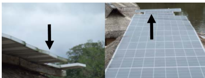
Figura 4 – Módulos de tamanhos diferentes constituindo um mesmo gerador.
