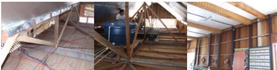
Figura 8 – Detalhes da fiação que constituía o sistema de distribuição e o sistema de iluminação.
