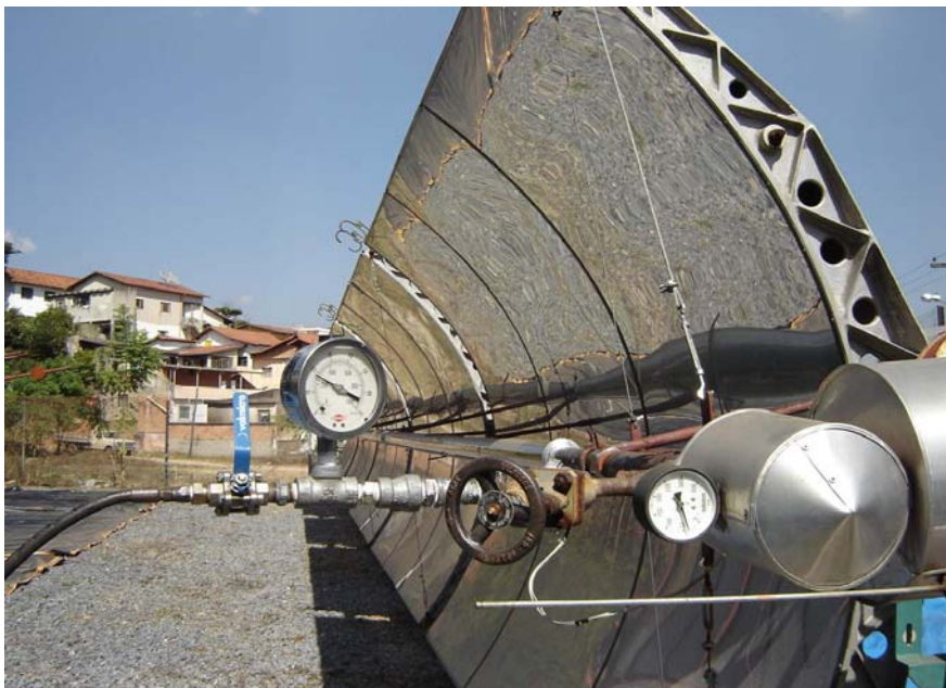
Figura 11-Linha 1: Teste Hidrostático da Tubulação –Usina Térmica Solar- CEFET-MG
