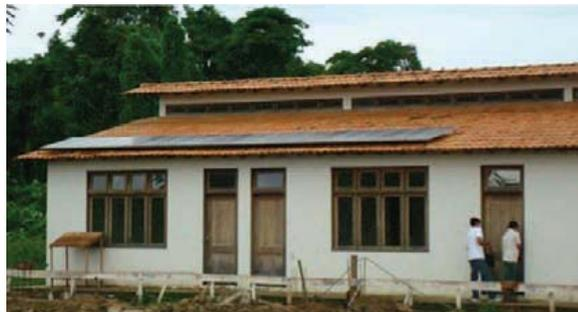
Figura 1- Sistema fotovoltaico integrado a edificação do laboratório.
