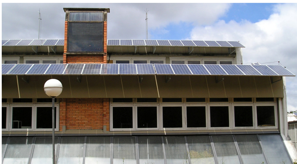
Figura 3 - Detalhe da fachada do prédio do Laboratório de Energia Solar mostrando os módulos do arranjo ensaiado e a célula de referência.
