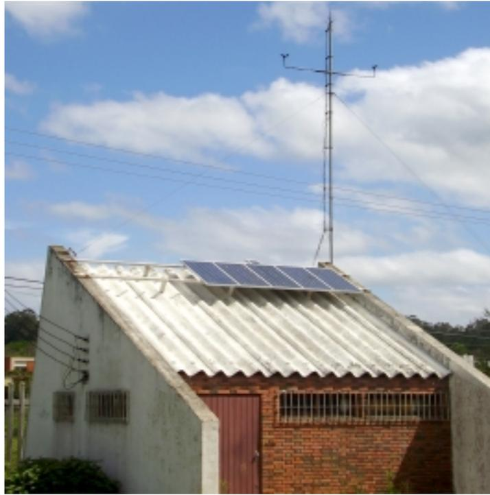
Figura 1: Sistema fotovoltaico autônomo com uma potência de 500Wp, instalado no prédio anexo ao Laboratório de Energia Solar da UFRGS.
