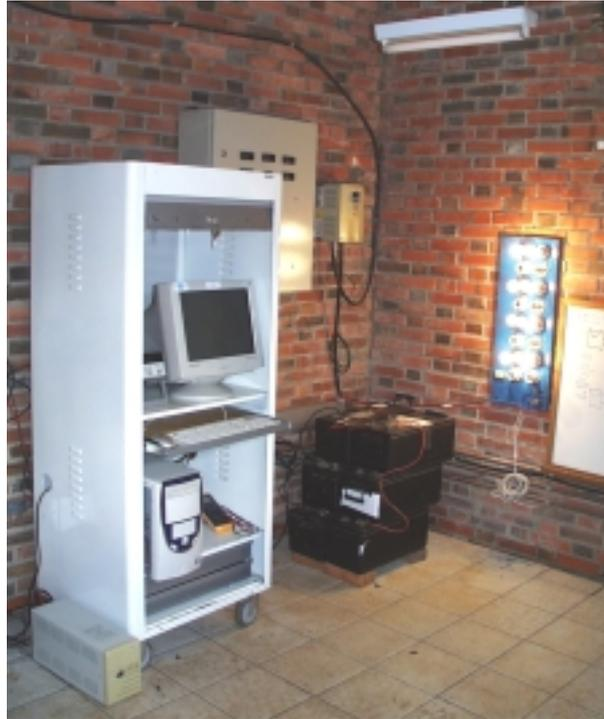
Figura 3: Sistema de monitoramento para da instalação fotovoltaica autônoma, cargas, banco de baterias e caixa de conexões elétricas.
